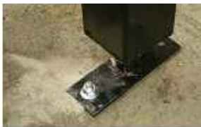
最後まで打込んだ写真です。
